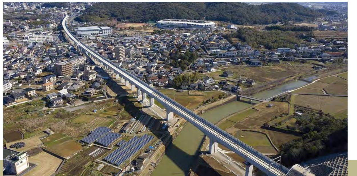
JR平山高架橋【長崎県諫早市】
