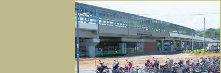
JR谷山高架橋 慈眼寺駅部【鹿児島市】
