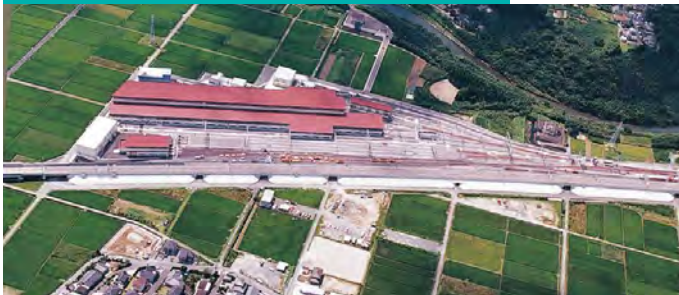
川内車両基地検修庫【鹿児島県薩摩川内市】
